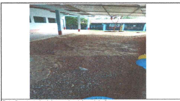
Foto 5: entortado del corredor del modulo 3
