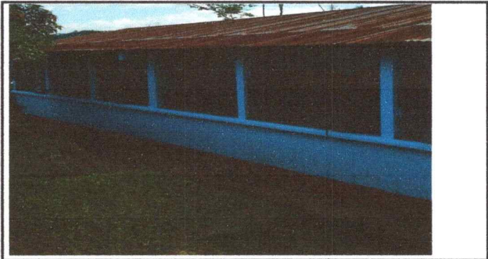
Foto 6: canales y bajada de agua pluvial
