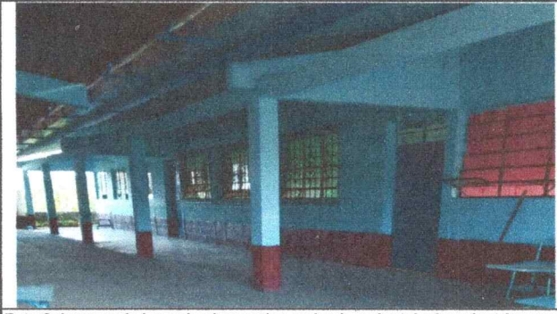
Foto 2: imagen de las aulas las cuales se les hara instalacion electrica por dentro y por fuera.
