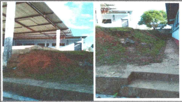
Foto 4: modulo 3 que necesita del muro perimetral para p
