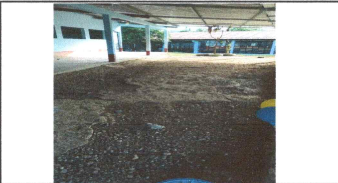
Foto 5: entortado del corredor del modulo 3
